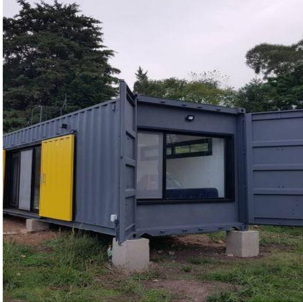
**Figura 12:** Container sobre as sapatas isoladas.
