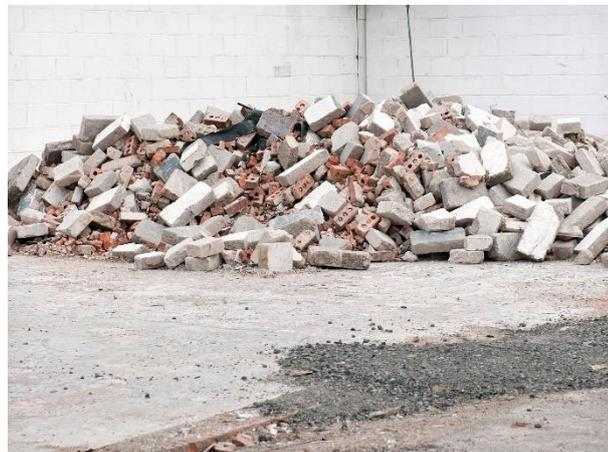
**Figura 02: Resíduos sólidos gerados pelo método construtivo de alvenaria convencional.**
