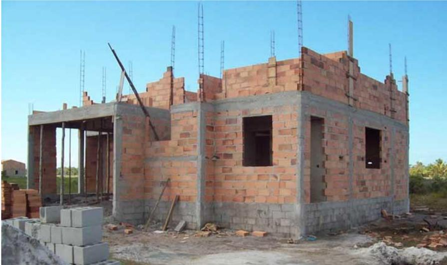
**Figura 1: Casa construída de alvenaria convencional.**
