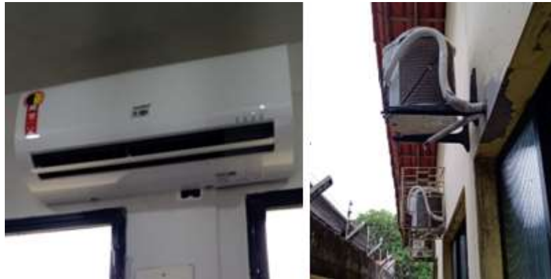
Figura 6: Modelo de aparelho, do tipo split, utilizado na unidade. Fonte: Autores, 2022.
