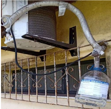
Figura 4: Galão acoplado à mangueira para coleta da água. Fonte: Autores, 2022.
