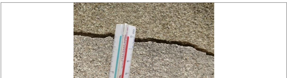
Figura 07. Rachadura.
