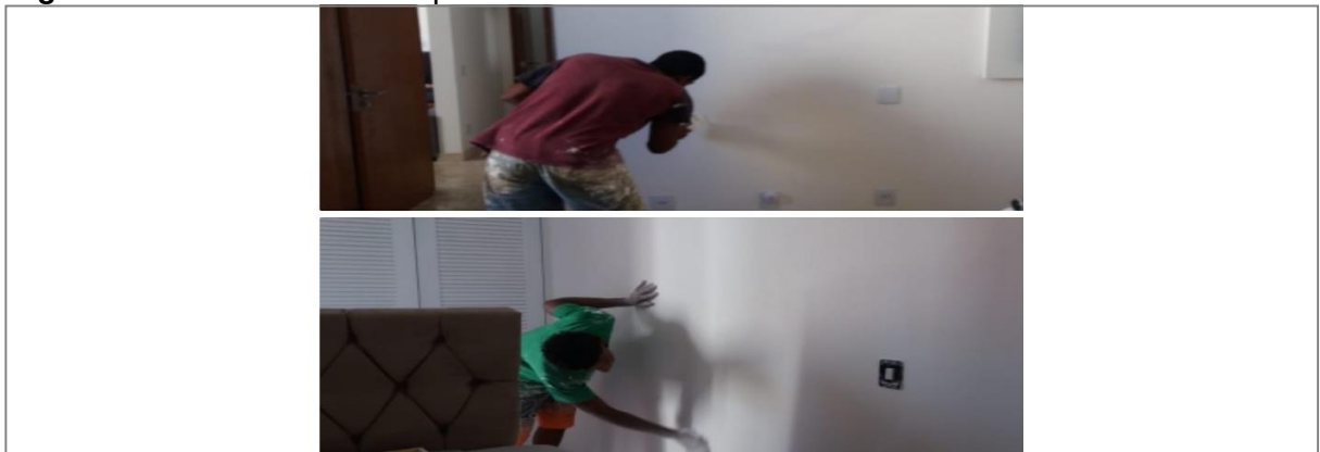
Figura 11. Nivelamento da superfície da alvenaria.
