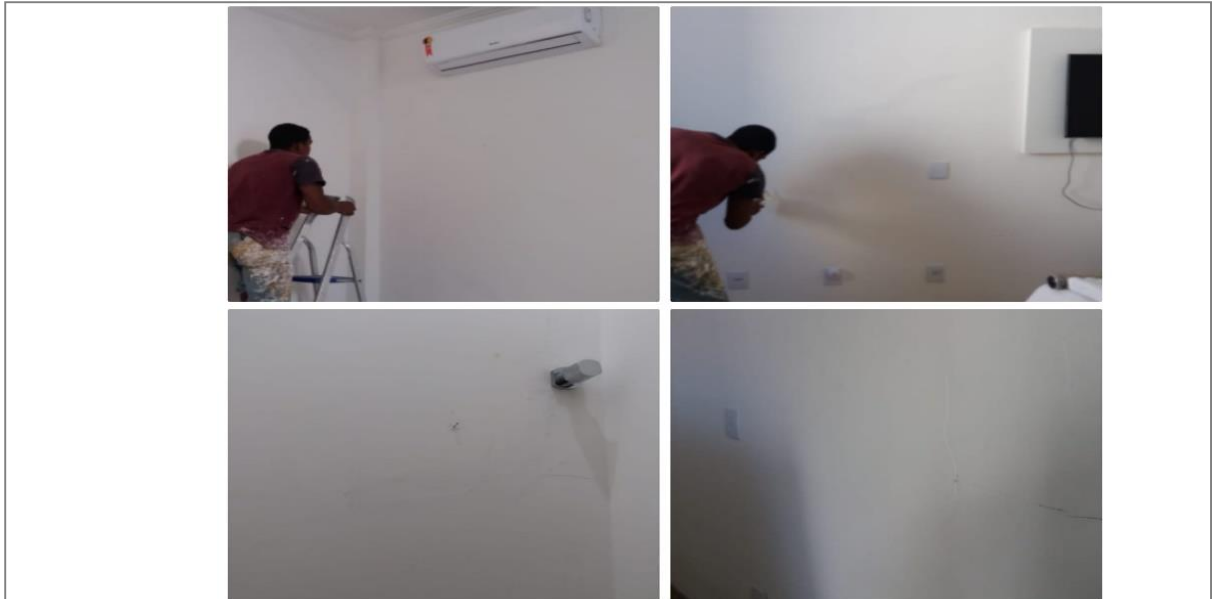
Figura 10. Aplicação da massa acrílica na superfície do reboco.
