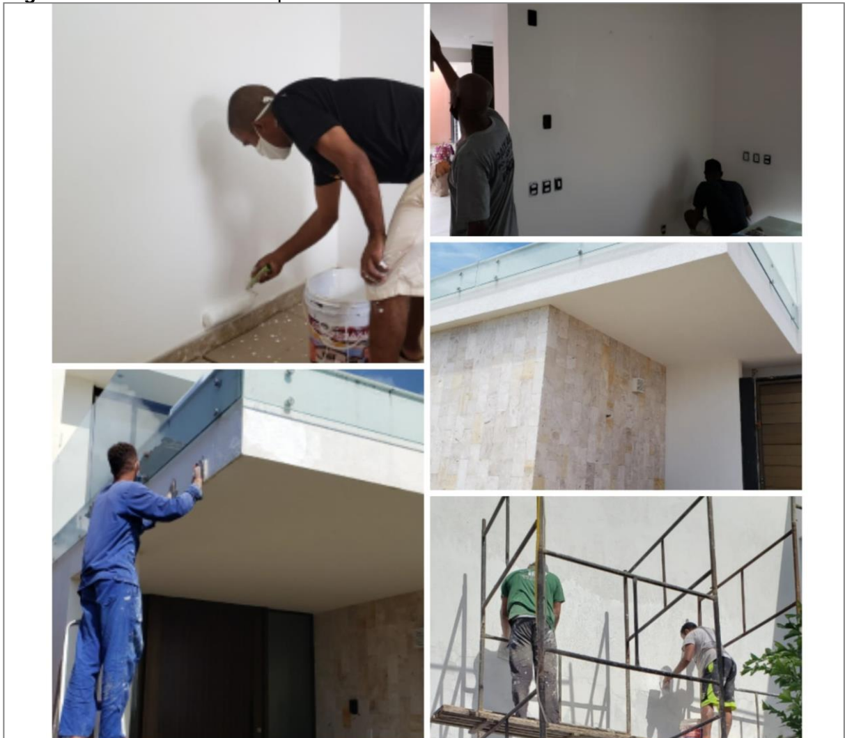
Figura 12. Nivelamento da superfície da alvenaria.
