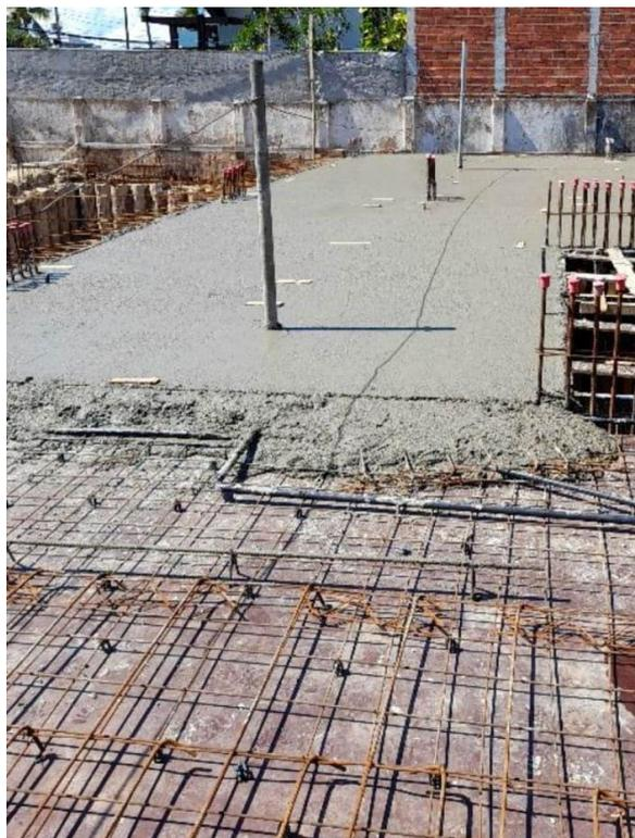
**Figura 1:** Concretagem de laje maciça de concreto armado. Detalhe do uso de espaçadores nas armaduras da laje. (Fonte: autor).
