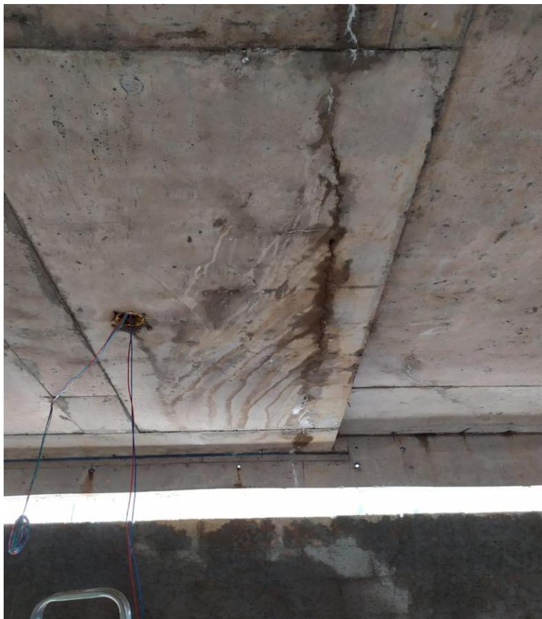
**Figura 5:** Fissuração na rampra do térreo. (Fonte: autor).
