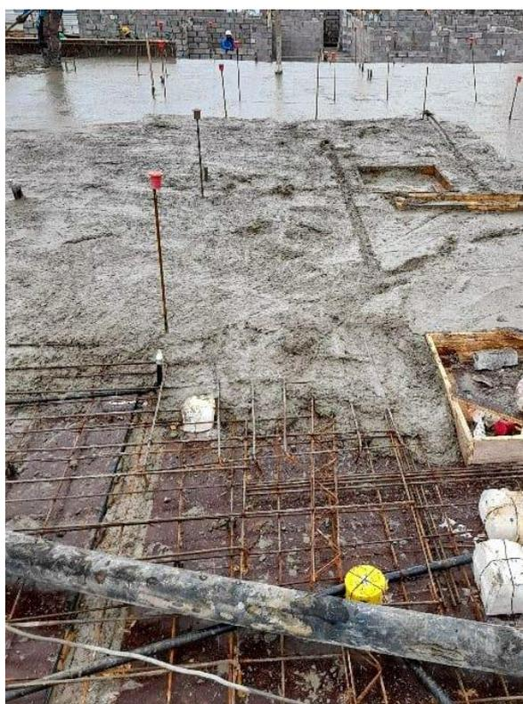
**Figura 2:** Concretagem de laje maciça de concreto armado. (Fonte: autor).
